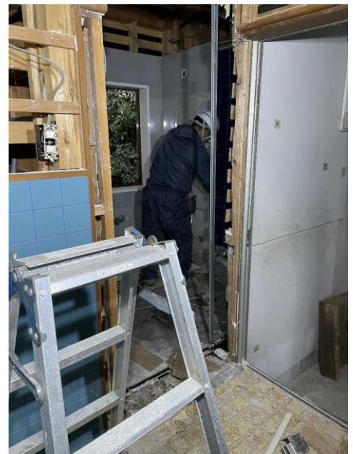
解体業者による作業
